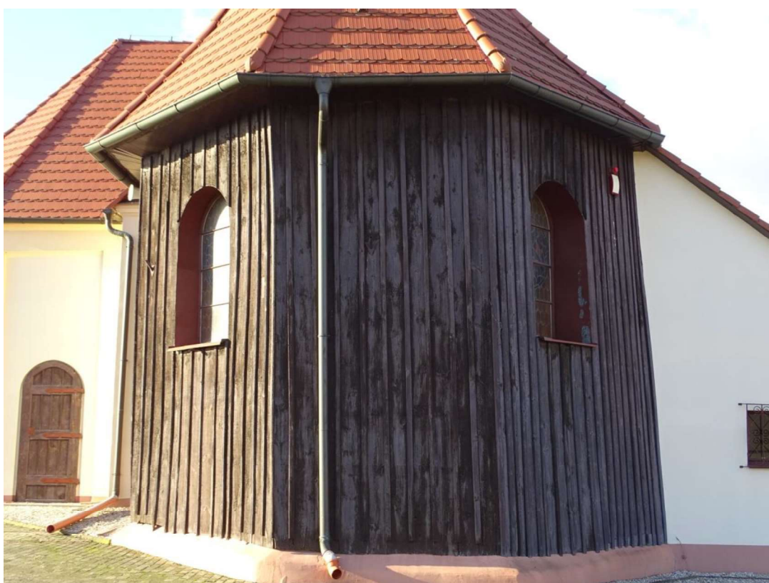
Fot.54 Kościół w Sobiańkowie – drewniane ściany trójbocznie zamkniętego prezbiterium
