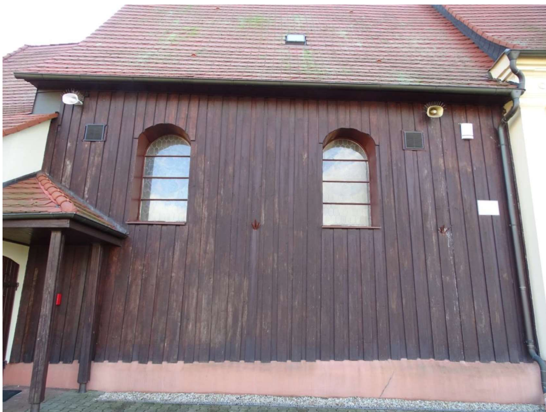
Fot.53 Kościół w Sobiańkowie – drewniana, północna, zewnętrzna ściana nawy
