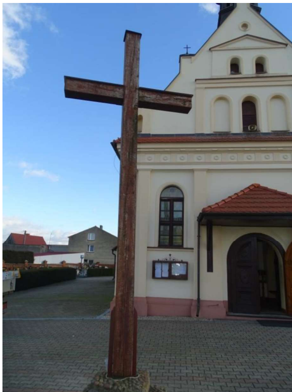
Fot.37 Wypłowiła warstwa ochronna oraz ubytki lakierów
