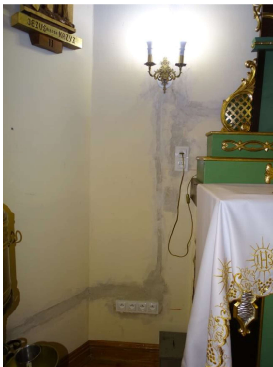
Fot.13 Wstępnie uzupełnione bruzdy po wymianie instalacji
