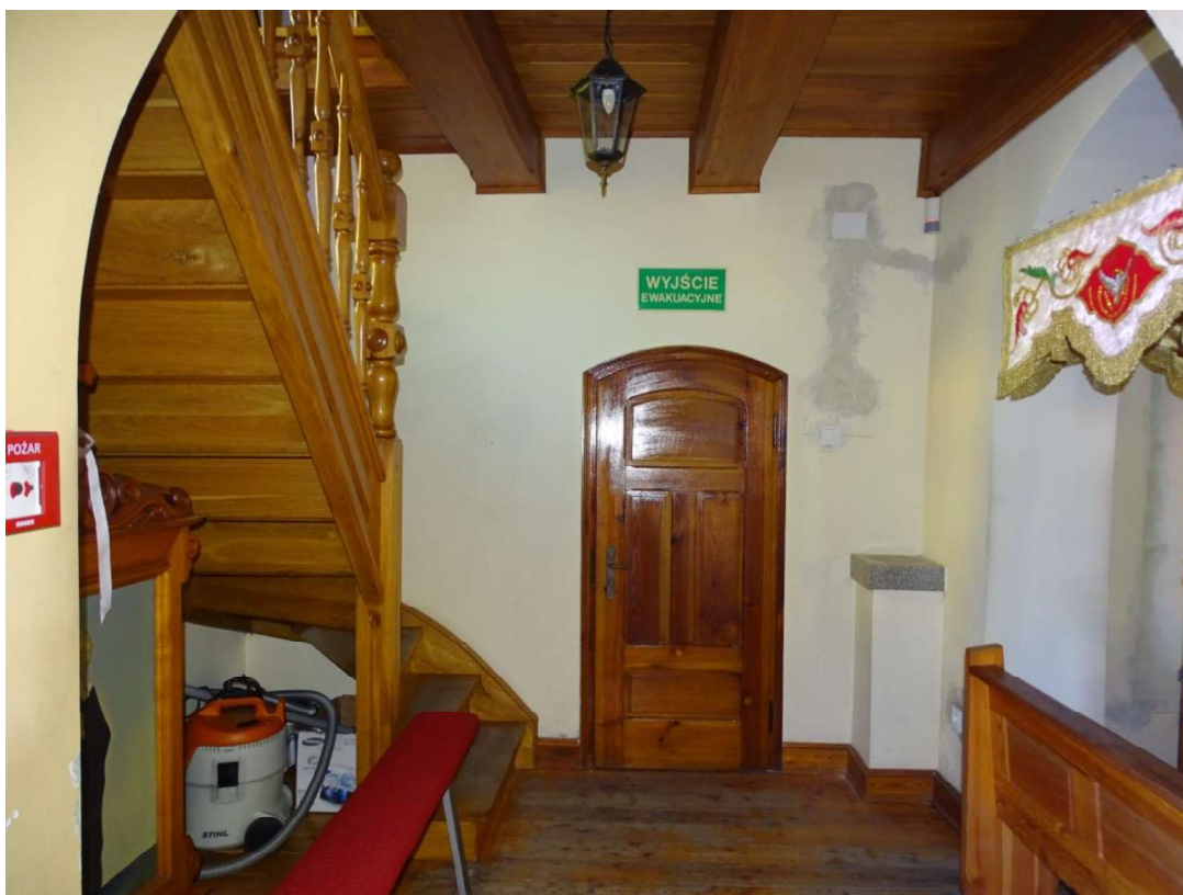
Fot.15 Wstępnie uzupełnione bruzdy po wymianie instalacji
