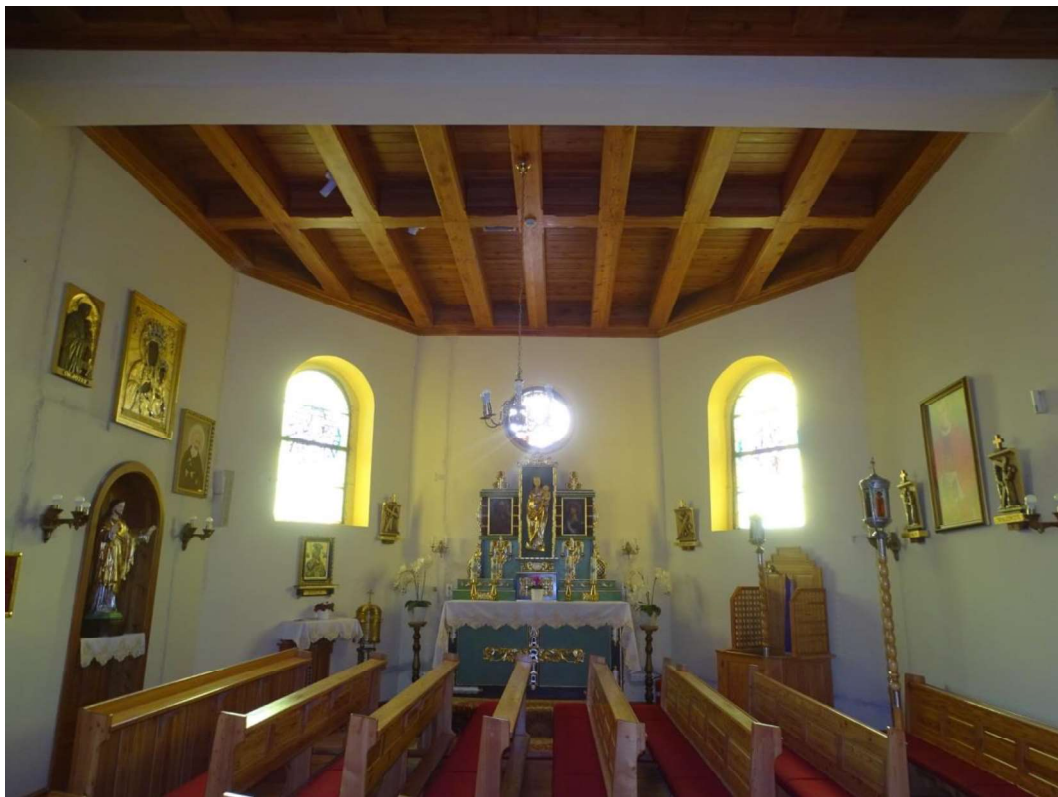
Fot.17 Strop belkowy nad kaplicą
