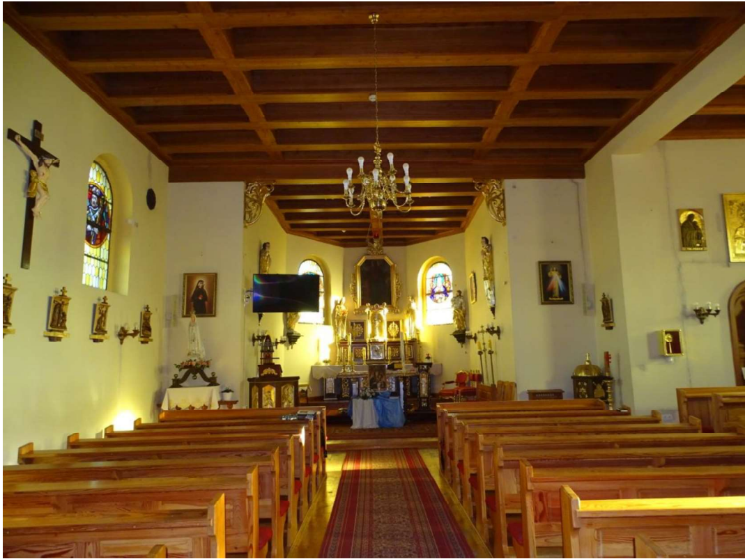
Fot.17 Strop belkowy nad nawą i prezbiterium
