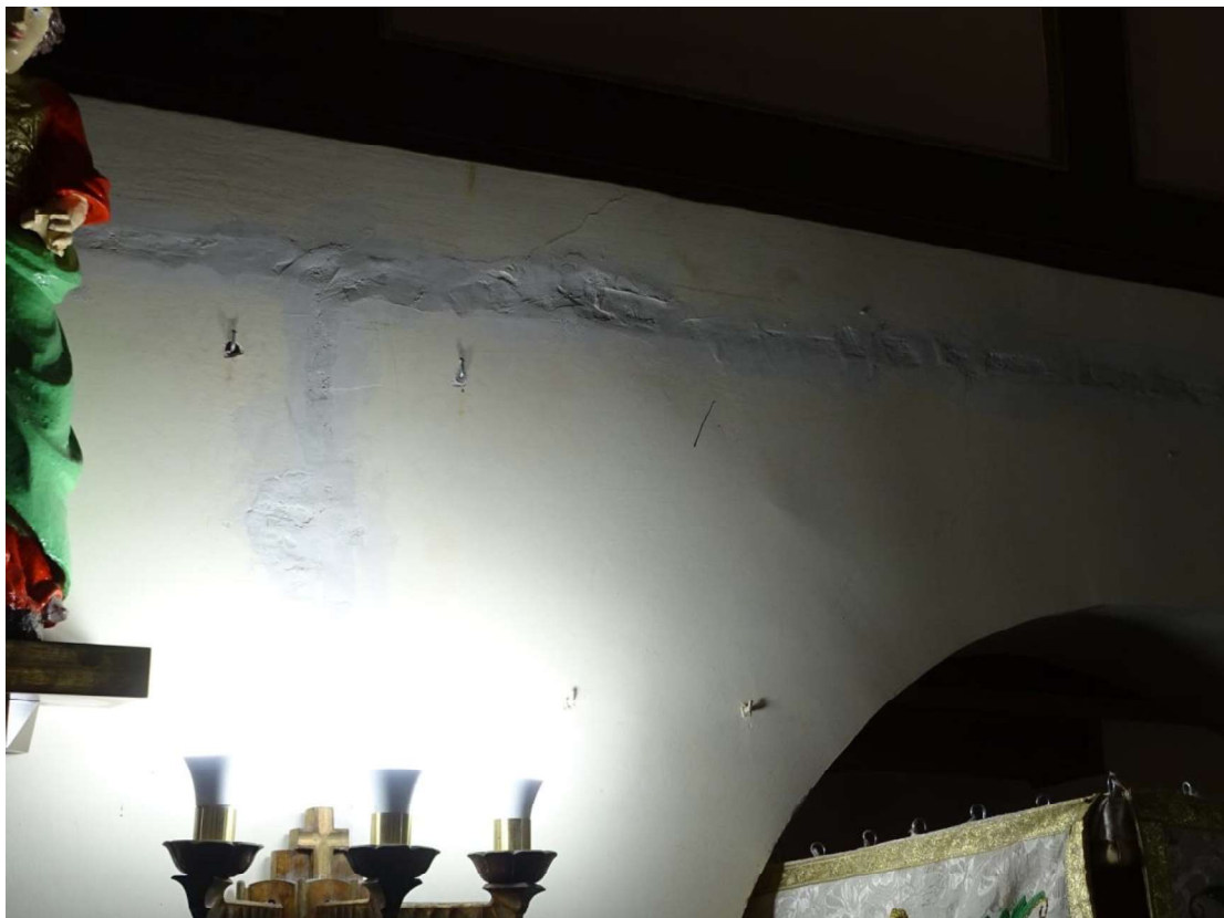
Fot.12 Wstępnie uzupełnione bruzdy po wymianie instalacji
