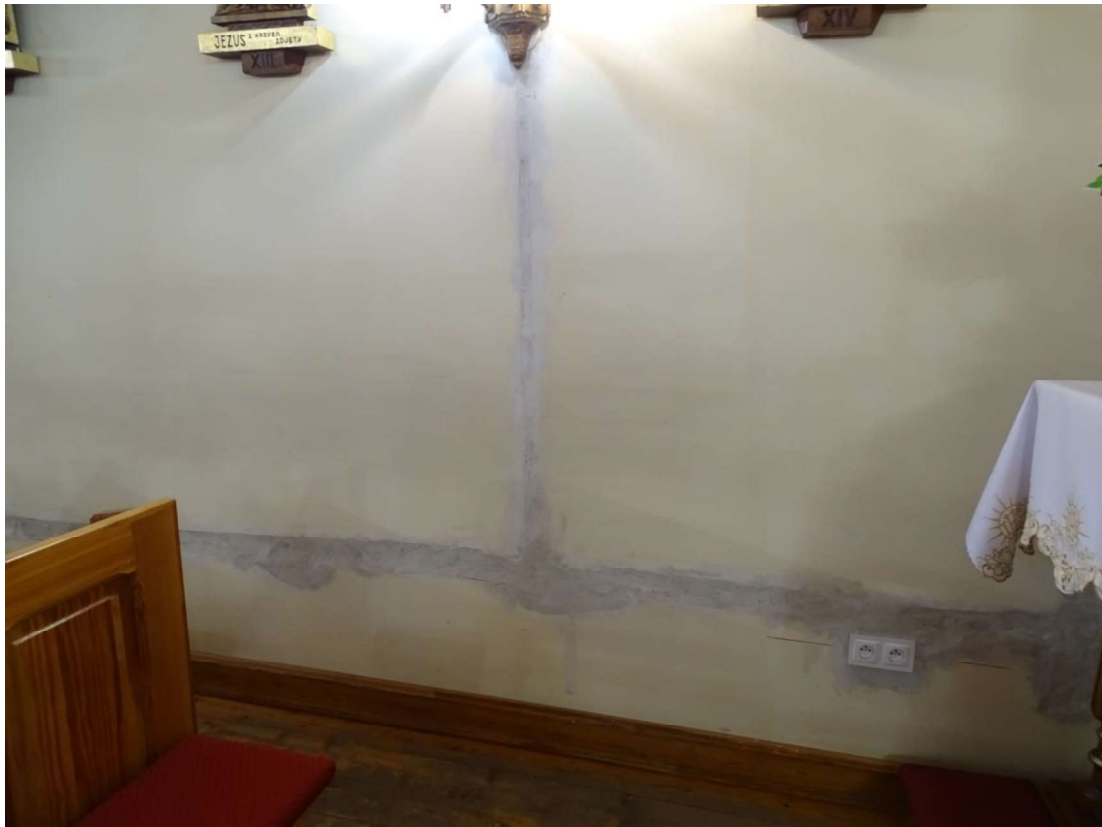
Fot.11 Wstępnie uzupełnione bruzdy po wymianie instalacji
