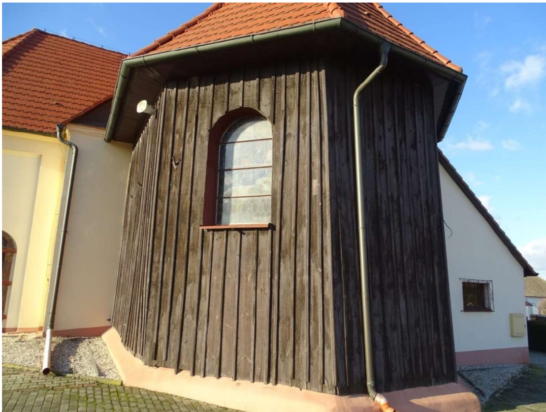
Fot.55 Kościół w Sobiałkowie – drewniane ściany wschodniej i południowej strony prezbiterium
