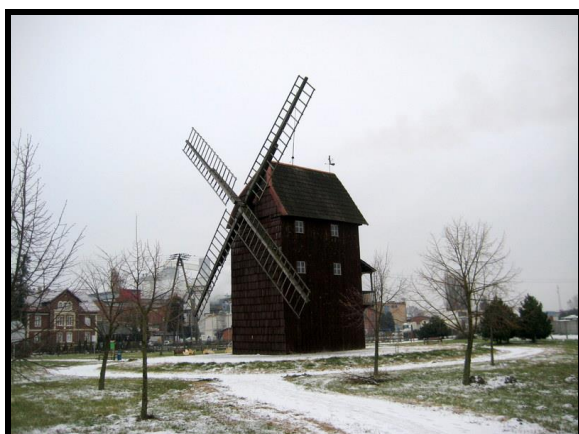
Zabytkowy wiatrak oraz miejsce integracji i rekreacji mieszkańców
