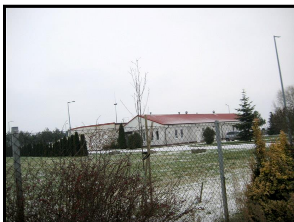
Oczyszczalnia ścieków w Karolinkach
