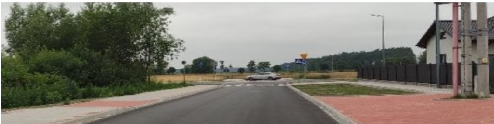
Rozbudowa drogi gminnej w Miejskiej Górká, ul. Hubala
