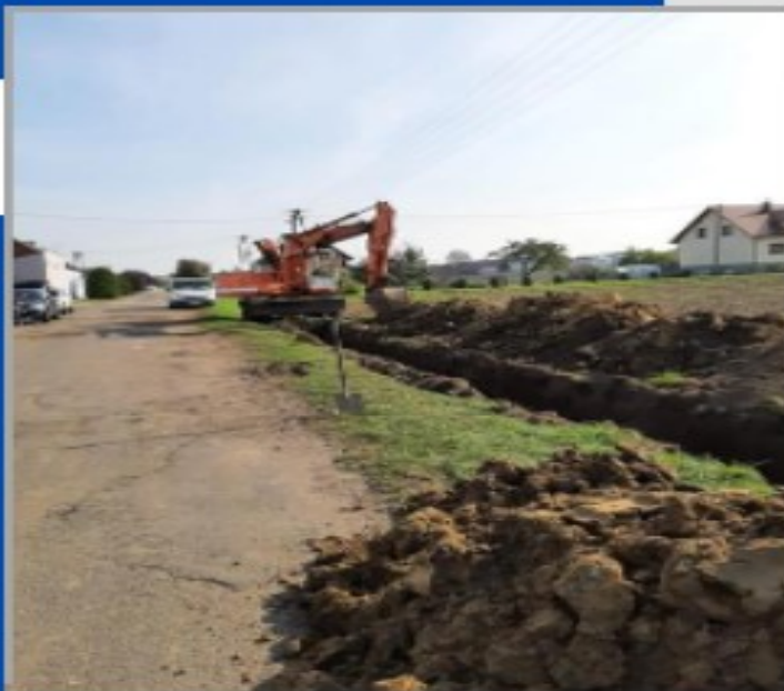
BUDOWA KANALIZACJI SANITARNEJ W SOBIAŁKOWIE
